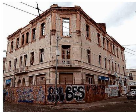
ESTE EDIFICIO SE INCENDIÓ EN 2016 Y AÚN NO SE HA RECUPERADO.
